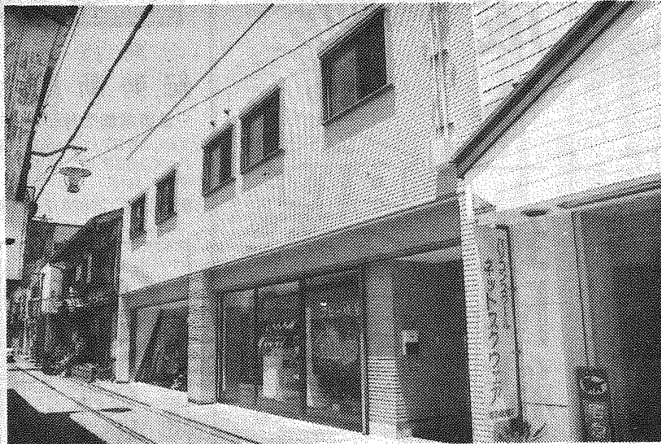
尾鷲一番街の中核となる敷地120坪の大型店舗
